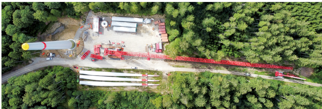
Abbildung 2: Lagerflächen und Fläche für den Aufbau des Kranauslegers zur Anlagenerrichtung © Ingenieurbüro Sing / Lorenz Hartleitner
