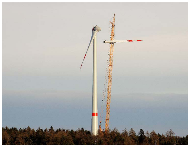
Abbildung 11: Anlagenerrichtung im Windpark Brenntenberg, Landkreis Regensburg (Bayern)
