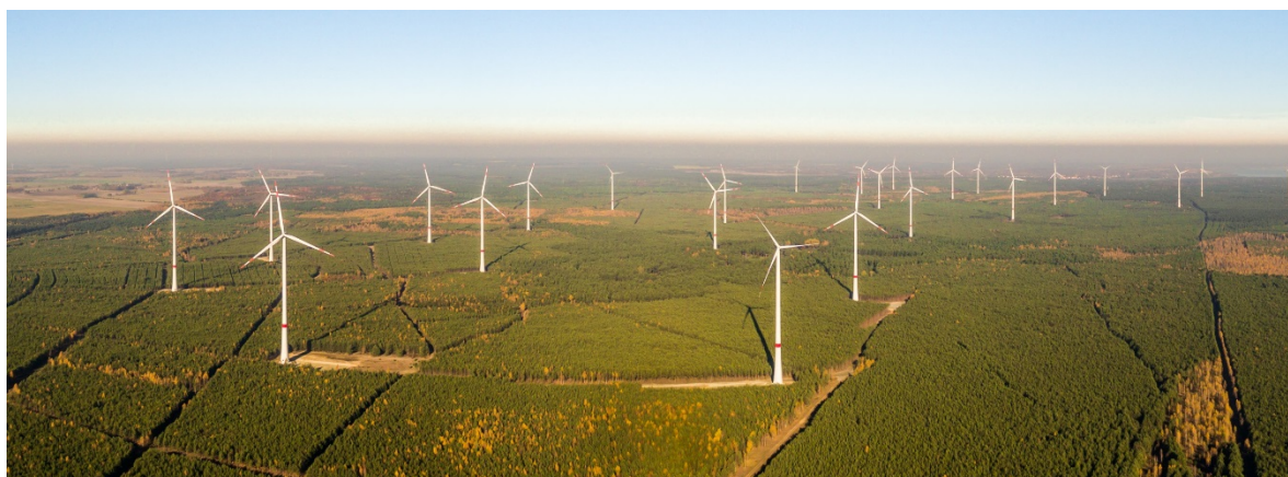
Abbildung 15: Windpark Chransdorf West im Landkreis Oberspreewald-Lausitz (Brandenburg)
