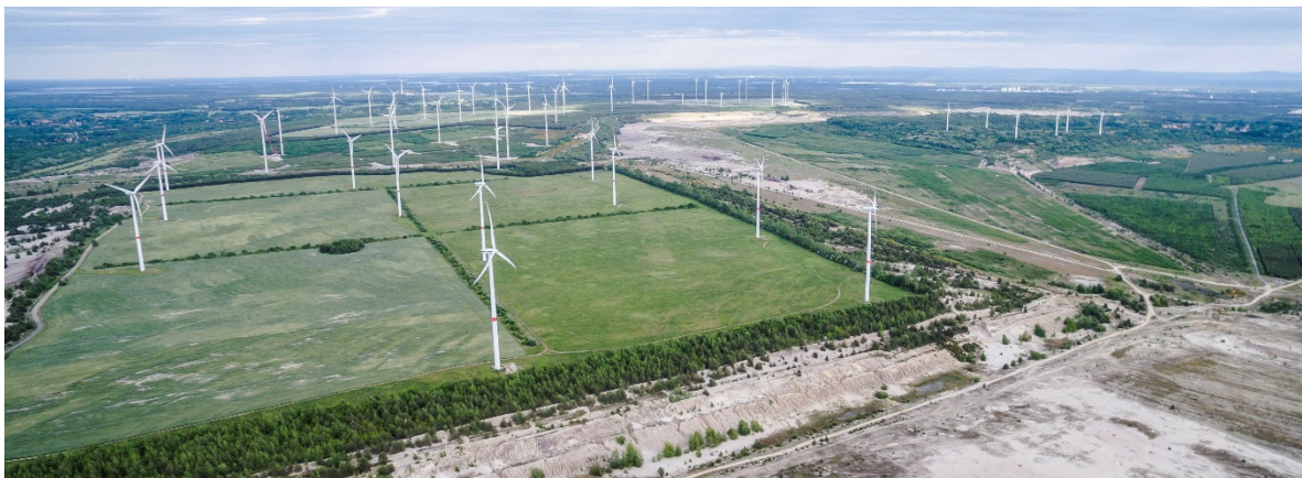
Abbildung 14: Repowerete Windenergieanlagen auf ehemaligen Tagebauflächen im Windpark Klettwitz, Landkreis Oberspreewald-Lausitz (Brandenburg)
